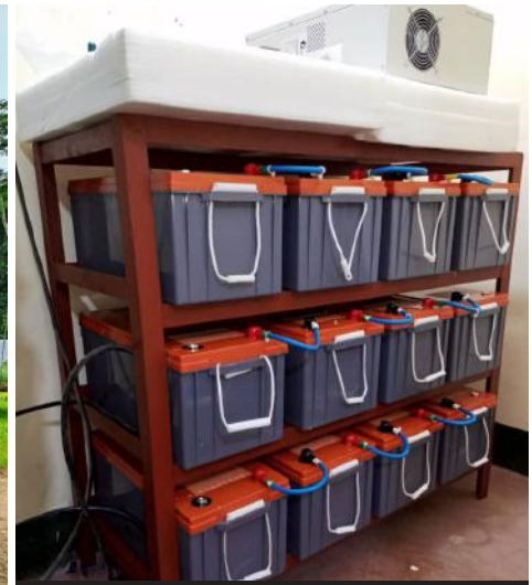
Montage et Couplage de 12 Batteries Gel de 200AH-12 V
