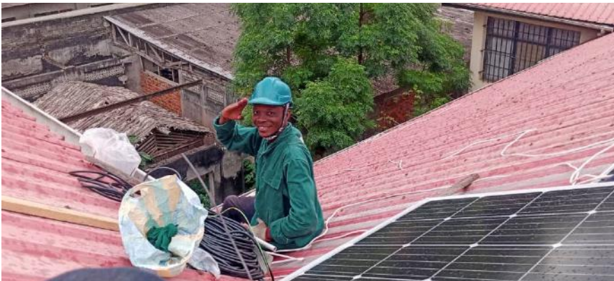
Pose des panneaux solaires sur le toit
