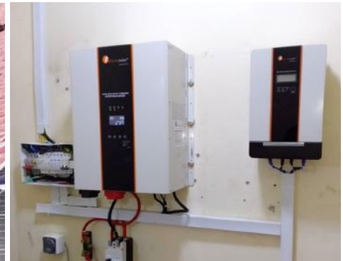
Fixation & montage du convertisseur Hybride de 7.500VA 48VDC
