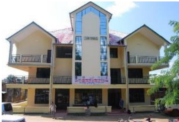
Fig. 33. Centre de Surveillance de la Biodiversité, Kisangani, RD Congo
